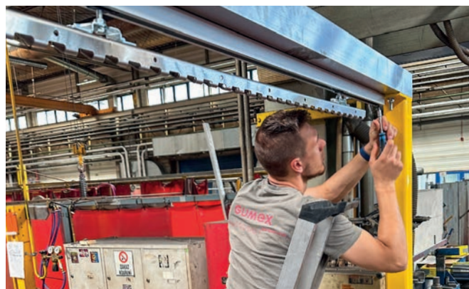
• Instalace posuvného uložení PVC závěsů
